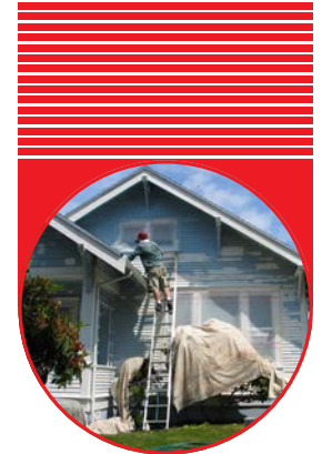
HOME RENOVATIONS REMODELACION DE VIVIENDA
