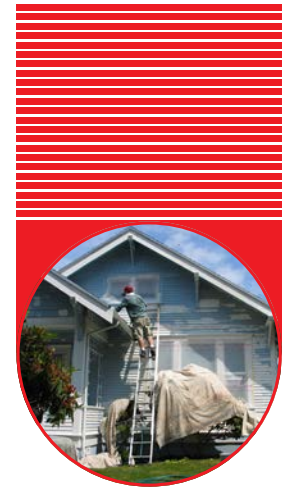
HOME RENOVATIONS REMODELACION DE VIVIENDA
